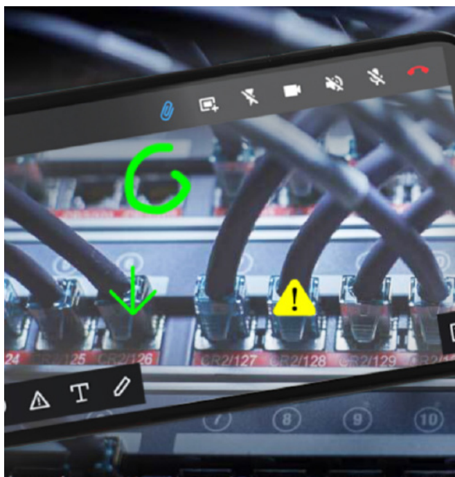
Figura 2: Smart Assistance prevede funzionalità di condivisione video e annotazione in tempo reale che favoriscono la collaborazione tra il personale in loco e quello da remoto per la risoluzione dei problemi di connettività.
