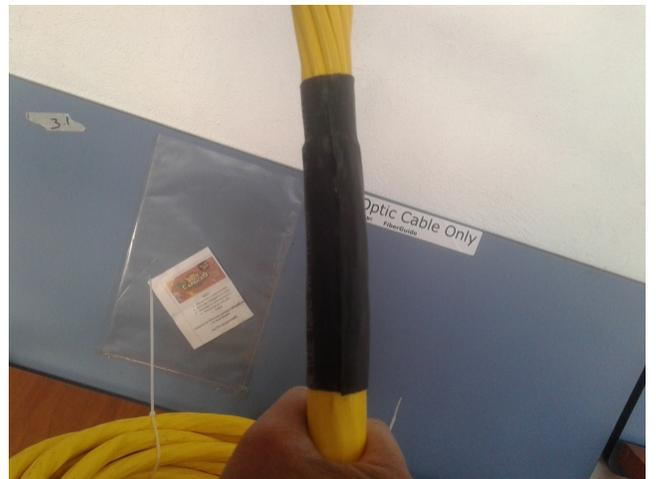
Una vez colocado el termofil, si la instalación se va hacer en el primer Chassis Universal, se debe sujetar con un Clamp y enrutar los tubos holgados hacia la parte izquierda del Chasis Universal por la trompeta superior, como lo muestra la siguiente imagen.
