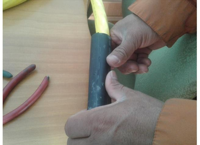
Finalmente, se calienta el termofil y queda listo para la sujeción dentro de las guías verticales de cableado del NG4.
