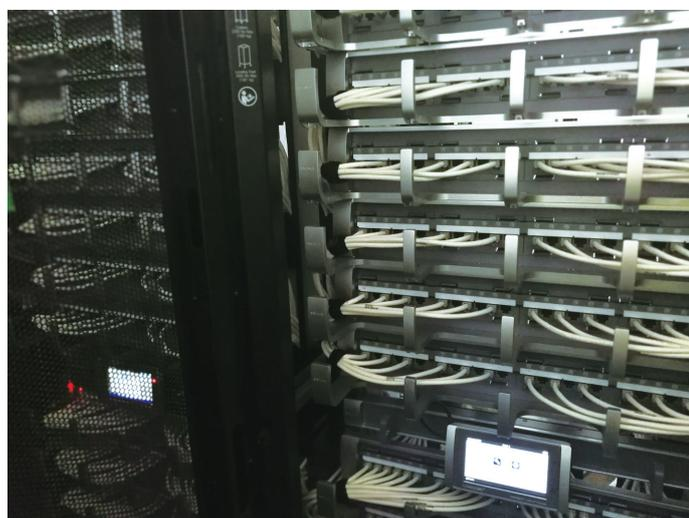
最后，在提高日常管理维护效率方面，康普 imVision® 智能基础设施管理系统解决方案表现出色。该方案的远程管理功能配合电子工单，在信息点位分散、安全级别高的生产区域，减少了 IT 管理人员往返的时间，可第一时间对特定区域进行维护管理操作；系统的故障告警功能，能及时主动地通知 IT 管理人员设备宕机下线的信息，减少故障排查时间，提高了维护效率，可消除潜在风险，同时又为网络稳定可靠运行提供了保障。方案中的 SYSTIMAX 360 iPatch 铜缆电子配线架具备在线零宕机更换有源监控器件的功能，配合标准 8 针电子配线架跳线应用，极大地提高了日常管理维护的便利性，同时又能确保网络运行的稳定可靠，可谓一举多得。
